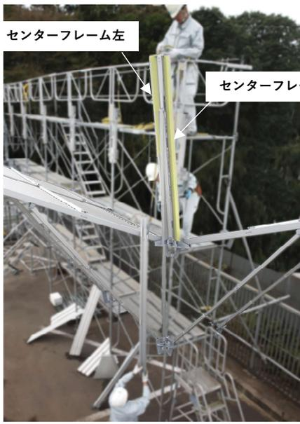
センター主材のパイプにセンターフレームのピンを差し込みます
