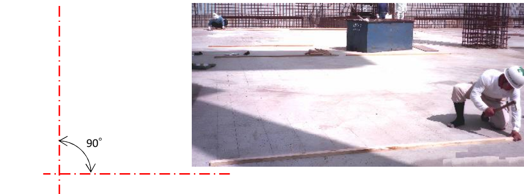
① 水平な地組場所に大矩を墨出しする
