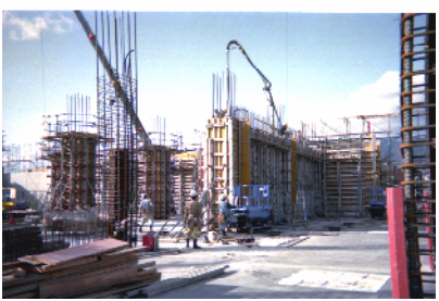
コンクリート打設
