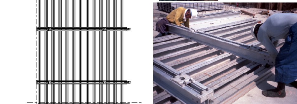
⑦ 合板を貼り付ける。
